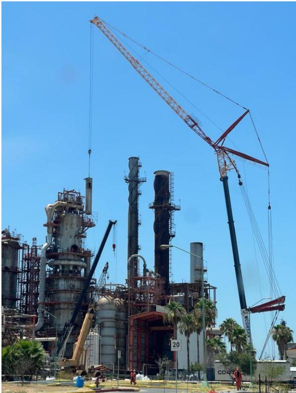
DESMONTAJE DE RISER Y DESMONTAJE DE CICLONES PRIMARIOS DEL INTERIOR DEL CONVERTIDOR DE PLANTA CATALITICA.
