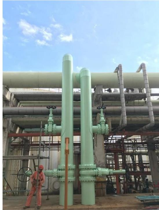
INSTALACION DE VALVULAS DE CONTROL, TUBERIA CONDUIT Y CABLEADO EN PLANTA DE ALKILACION No. 1 DE REFINERIA ING. HECTOR R. LARA SOSA DE CADEREYTA N.L.
